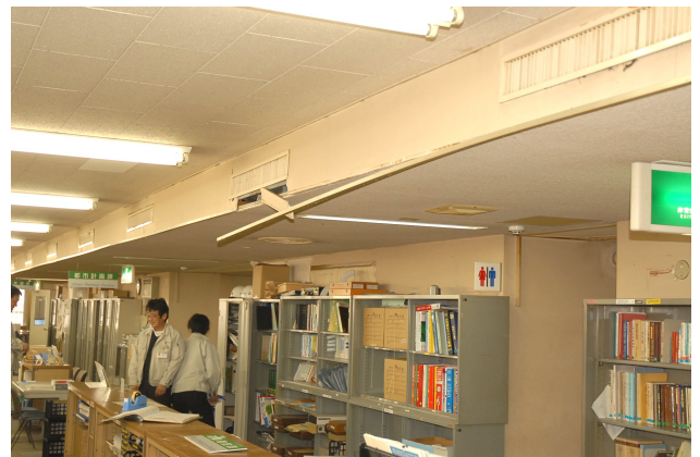
(市役所本庁舎スモークフェンス及び天井の損壊)
