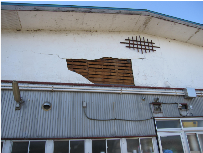
〔市立大宮保育所（当時）の建物の一部損壊と液状化被害〕
