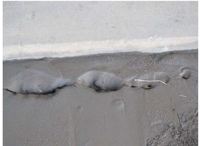
〔市立大宮保育所（当時）の建物の一部損壊と液状化被害〕
