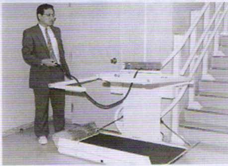
●愛宕中階段に車いす昇降機
