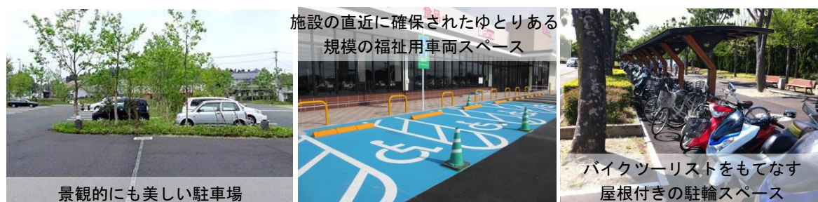
図－ 6. 駐車場等の整備事例
