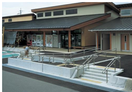
高低差を解消するスロープの設置
