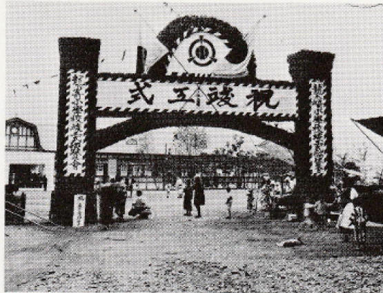
現在地にできた龍小新校舎の竣工式
