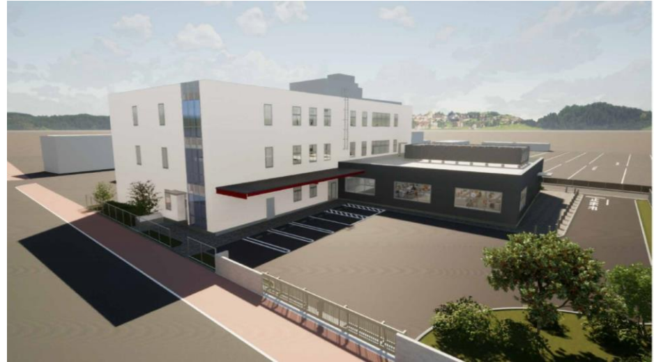
県道側からの外観
