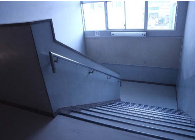
階段1 (校舎棟側)
