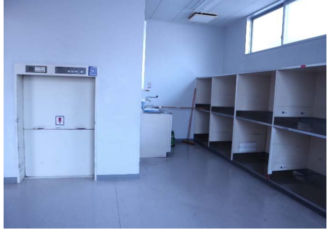
<配膳室> 昇降機
