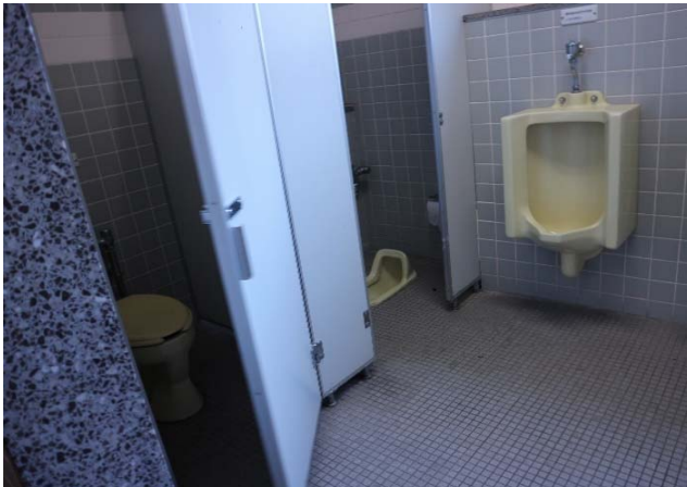
<トイレ> 洋式・和式トイレ
