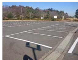
▲駐車場区画線改修
